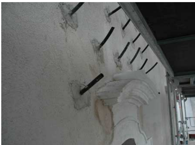
Iniezione di calce idraulica
